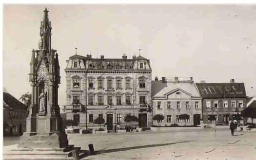
Obrázek 31 - Budova Rabštejna pohled z Palackého nám.
